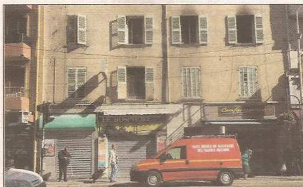
Hier, une équipe de recherche des causes d'incendie est revenue sur les lieux.
