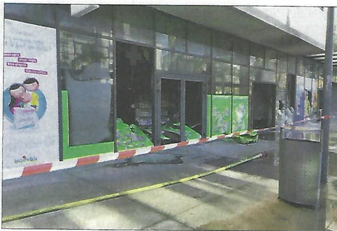
Le feu est parti de la pharmacie au rez-de-chaussée du centre commercial de Ranguin. Jusqu'à 41 pompiers et 22 engins ont été déployés au plus fort de l'intervention.
